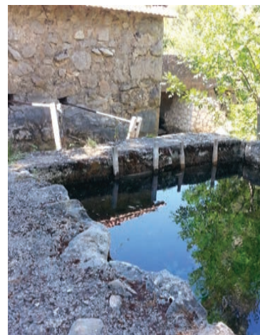
37. Ustave za vodu u Ljubičića mlinu – Sluices at the Ljubičića watermill – Schleusen in der Ljubičić-Mühle
