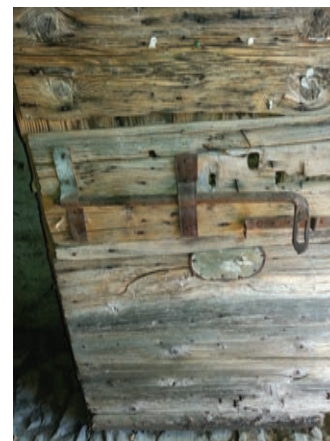
64. Drvena vrata sa kračunom – Wooden door with a latch – Holztür mit Riegel
