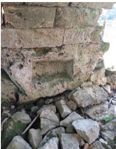
87. Ostava za oku i alat uklesana u sedri – A storage space for the oka container and the tools carved in the tufa – Aufbewahrungsort für das Mehlmaß und Werkzeug im Travertin eingemeißelt
