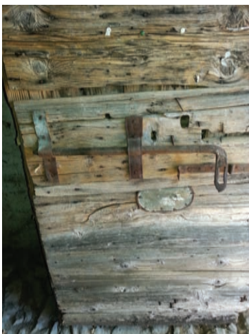
35. Vrata sa kračunom u Ljubičića mlinu – Door with latch at the Ljubičića watermill
