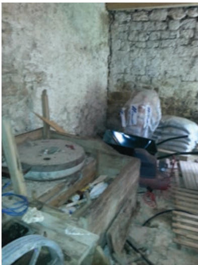
76. Odužilo se uređenje – A lengthy renovation – Die Renovierung zieht sich hin
