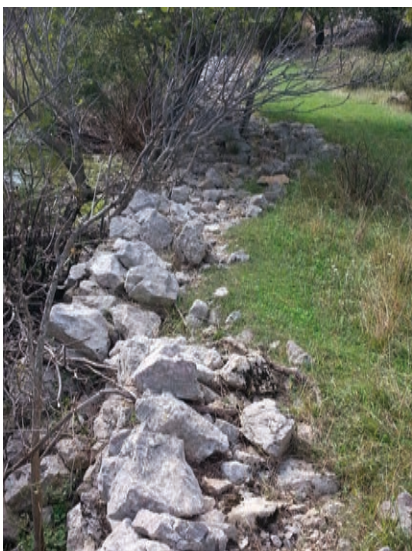
4. Podzidak kako voda ne bi odnjela dragocjenu zemlju – oranice prema Radovu buku
